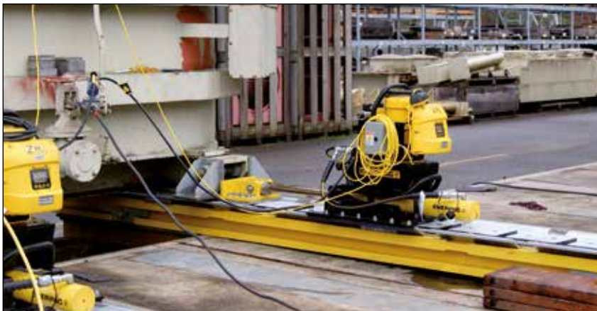
▼ Un système de débardage hydraulique bas (HSKLB) conçu sur mesure permet à l'équipe de maintenance de déplacer et de transporter les transformateurs dont l'accès est physiquement limité.
