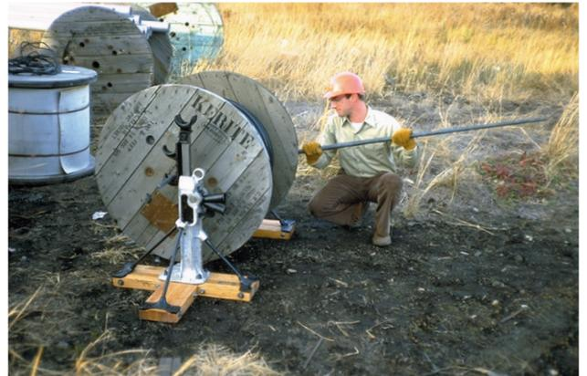
Mise en œuvre de vérins pour bobines de câbles CRA1029
