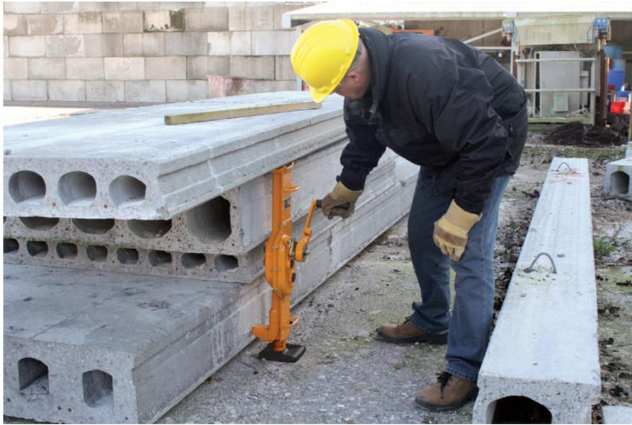
Un CJ50 (5 tonnes) utilisé pour créer un espace entre deux dalles de béton plates
