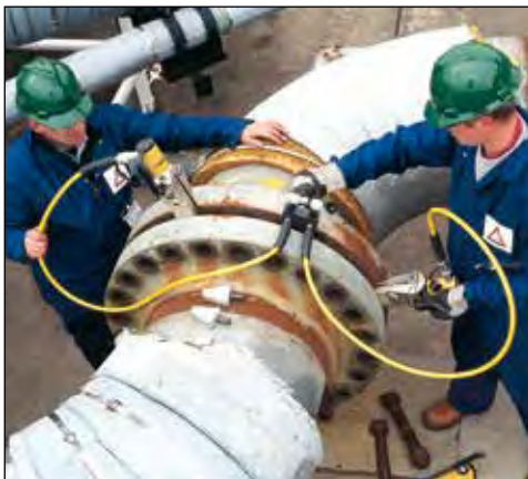
◀ Deux écarteurs FSH-14 utilisés simultanément avec la pompe manuelle Enerpac, les flexibles et le bloc foré pour partage du débit AM-21.
